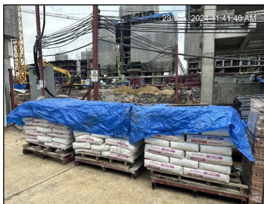
ภาพที่ 50 ผ้าใบปิดคลุมวัสดุก่อสร้าง
